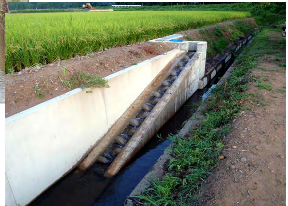
水田魚道の施工事例
