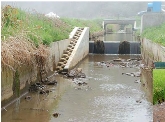
落差工魚道の施工事例
