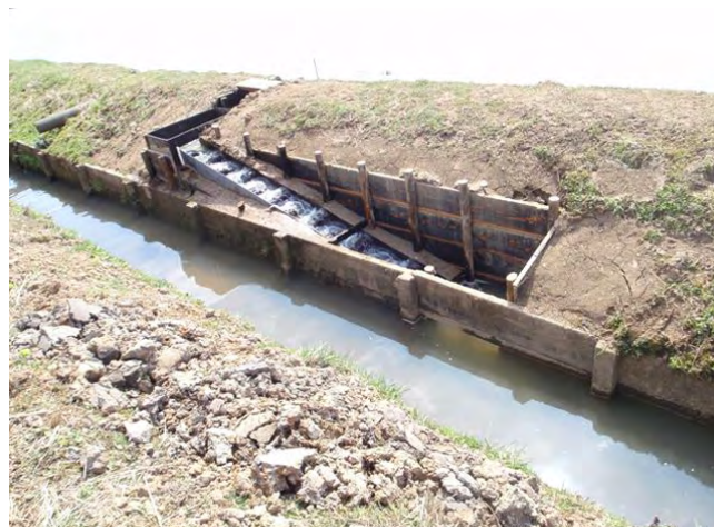
FRP製魚道の施工事例(2)
