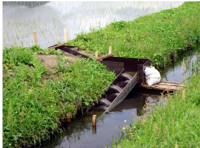
FRP製魚道の施工事例(1)
