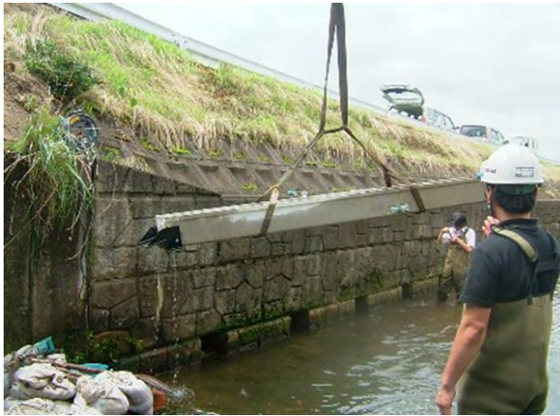
落差工魚道の施工事例
