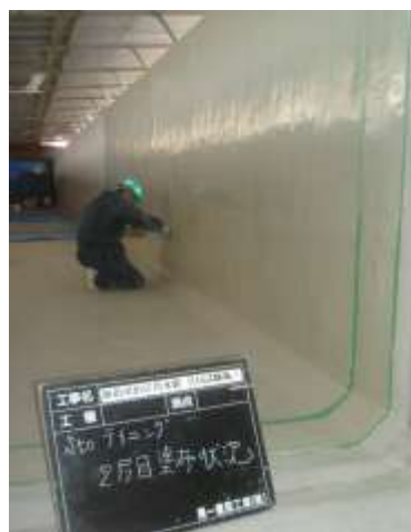
&lt;ライニング材塗布状況&gt;
