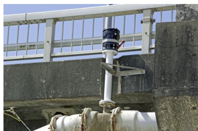
平成21年度ストックマネジメント技術高度化事業(来間島導水路対策工法施工工事)
