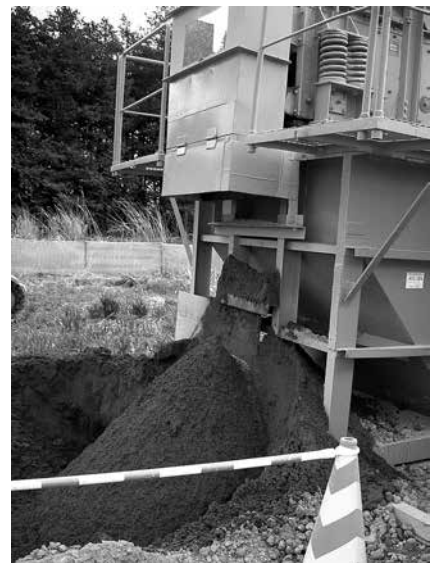
写真-2 排土処理状況
