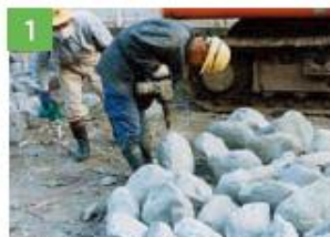
1 自然石を並べ、窄孔し、エアガン等で十分に清掃します。
