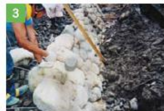
3 丁張り等にに合わせて、微調整を行いながら積上げます。ストッパーパネルは後方まで移動させてから裏込材を投入します。
