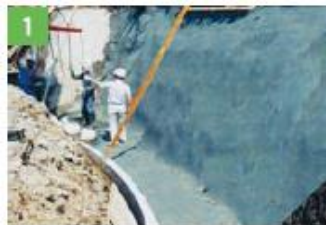
1 基礎コンクリートを打設し、吸出し防止材を敷設します。
