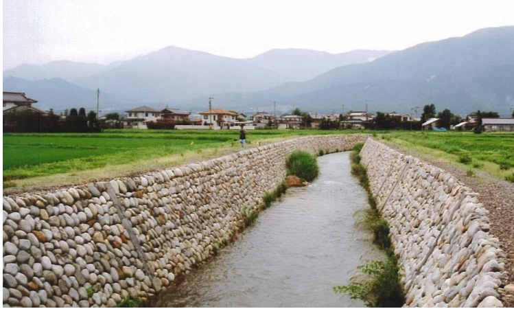
農水省 安曇野農業水利事業所 有明排水路
