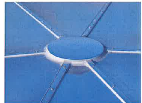
ガセットカバーと屋根パネル
