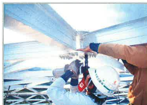
嵌合型ボルトによる締結作業
