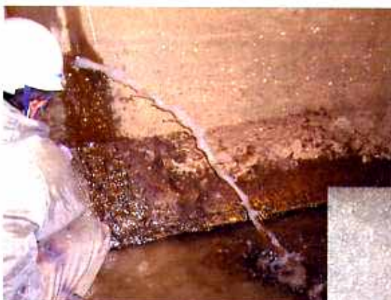
バンデフレキシシ工法を使って止水した東京都内の現場の様子。上はボックスカルバートの接合部から出水している様子。右は、カルバートに削孔してノズルを挿入し、止水材を注入しているところ
