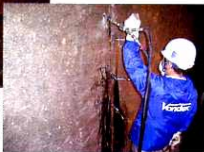
バンデフレキシシ工法を使って止水した東京都内の現場の様子。上はボックスカルバートの接合部から出水している様子。右は、カルバートに削孔してノズルを挿入し、止水材を注入しているところ
