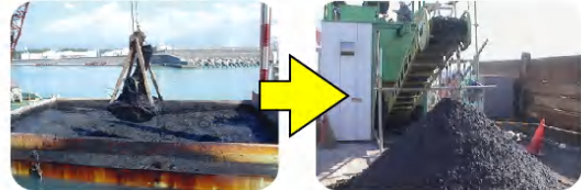
写真-2 施工状況
