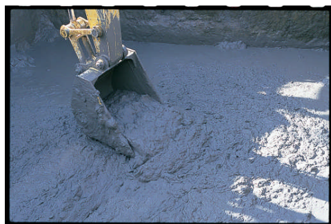
写真-1 石膏系固化材を用いた建設汚泥の再資源化利用例
