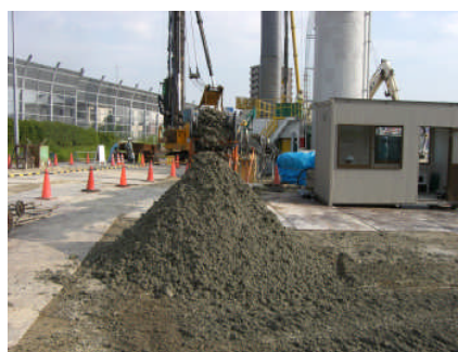
写真-1 石膏系固化材を用いた建設汚泥の再資源化利用例
