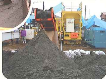
◀ 泥土圧シールド工法排泥
