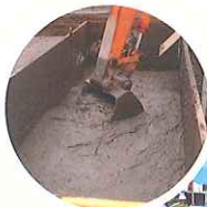
◀ 泥土圧シールド工法排泥
