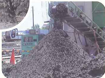
◀ 高圧噴射攪拌工法排泥
