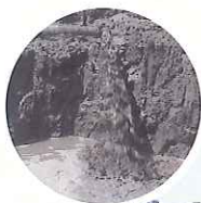
◀ 高圧噴射攪拌工法排泥
