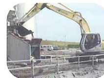
F 泥土投入
