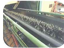
H 処理土搬送
