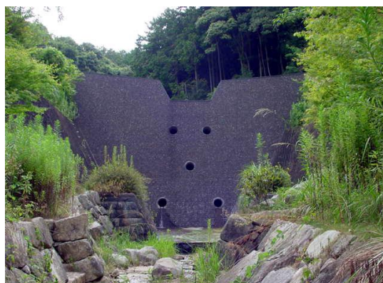
砂防堰堤(福岡県)
