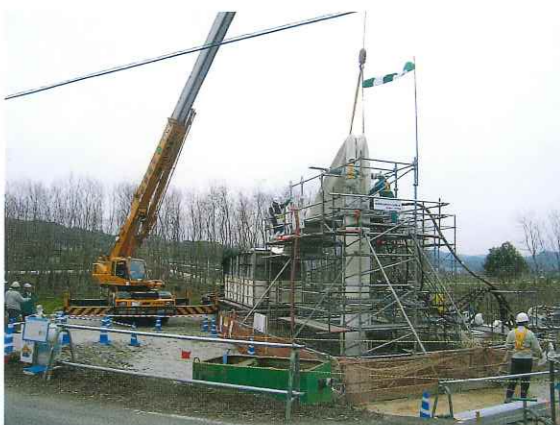
農業用水管更生工事 反転状況
