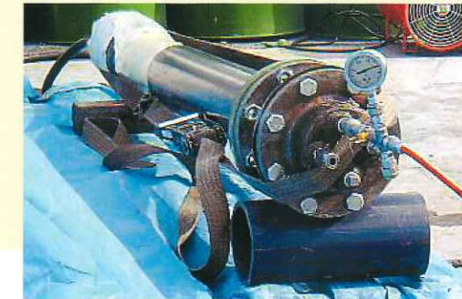
農業用水管更生工事 反転状況
