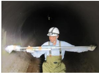
Pic2. 測定状況
