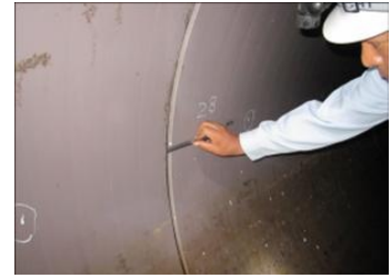
Pic4. 継手間隔測定
