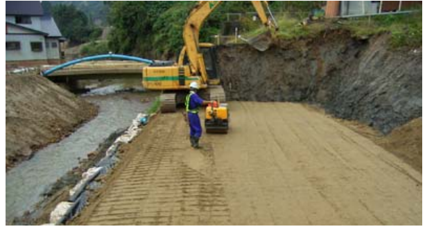
(a) 繊維質固化処理土の転圧
