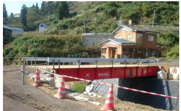
(c) 完成した仮設栈橋
