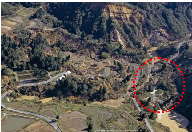
図-6 災害現場の全景
