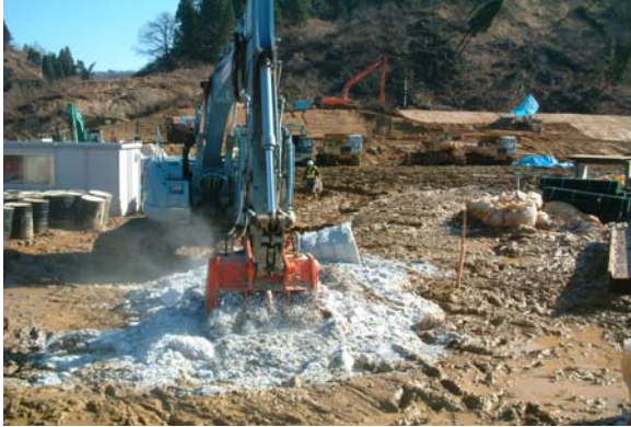
(b) 古紙破砕物を泥土と混合している様子
