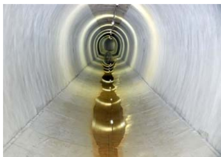
粗度係数の改善・耐摩耗性向上 (導水路トンネル)
