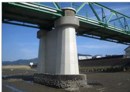
遮塩耐久性向上・河川阻害率低減 (橋脚耐震補強)
