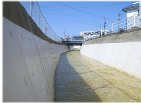
通水量・耐摩耗性向上(開水路)
