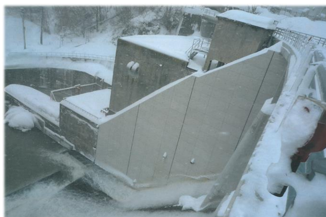
耐久性向上(ダム側壁)
