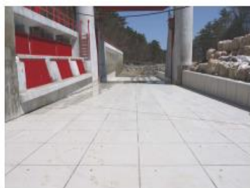
耐衝撃・耐摩耗に対する補強 (頭首工排砂ゲート)
