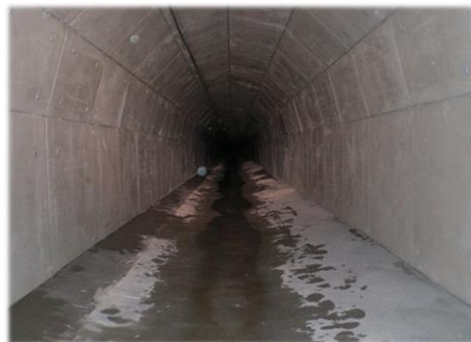
通水量・耐摩耗性向上(導水路トンネル)
