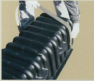
①パッキン貼付け
