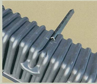
②浮上防止アングルの差込み
