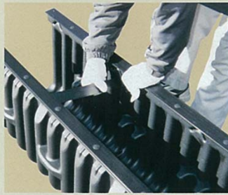
④突き当てアングルの取付け (下から斜に上げて取り付けてください)
