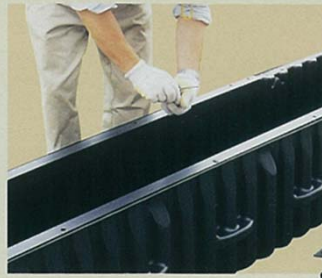
⑤重ね合せ部をボルトで 締付ける
