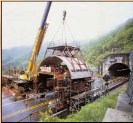
自走式組立て架台方式
