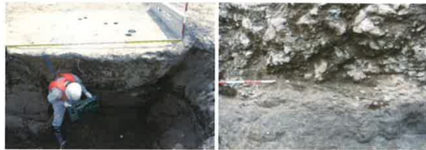
写真-4 打継部の確認状況
