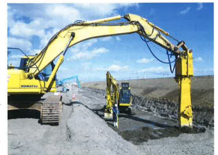
写真-7 施工状況
