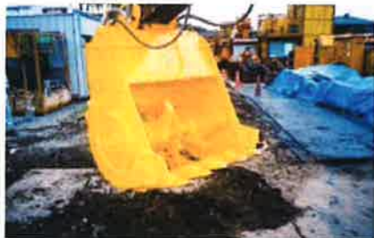
写真-2 バケットミキシング方式
