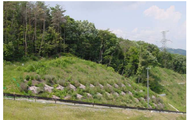
写真-1 施工地全景（平成 14 年 5 月撮影）
