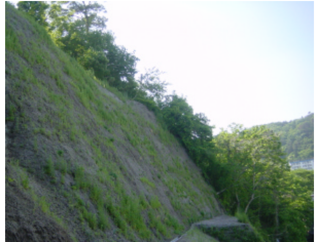
写真-1 施工8ヶ月後の状態（平成15年5月撮影）
