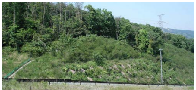
写真-5 施工地全景（施工2年11ヵ月後）
