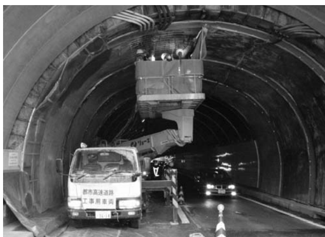
写真-1 トンネル坑口補強状況
