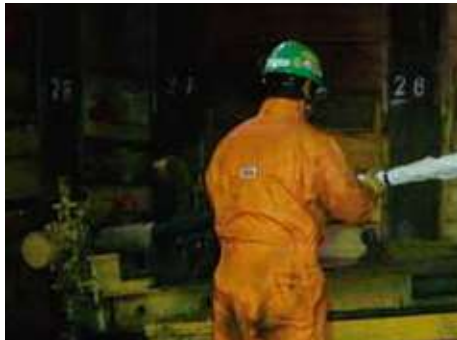
写真-5 注入外管の建込
