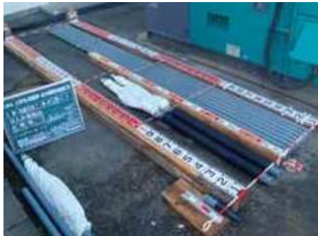
写真-4 エキスパッカ-N 工法の注入外管
