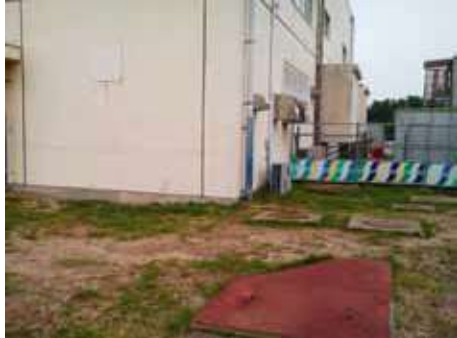
写真-3 液状化対策を施工した施設周辺は被害なし
