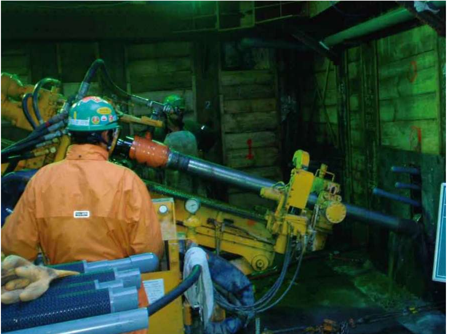
写真-1 既施設下部地盤の液状化防止工事（茨城県東海村）
