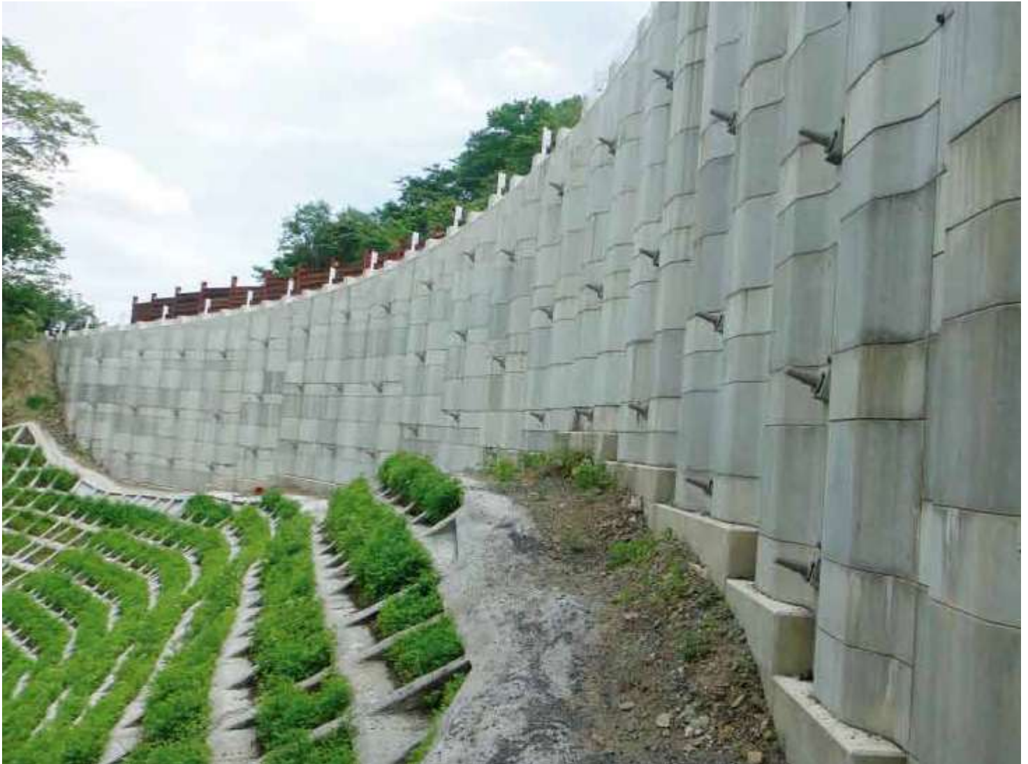
写真-1 震度 6 弱の揺れに耐え、国道 342 号線を守った親杭パネル壁工法（岩手県一関市・茂庭沢，壁体高 H=1.5-11.0m）
