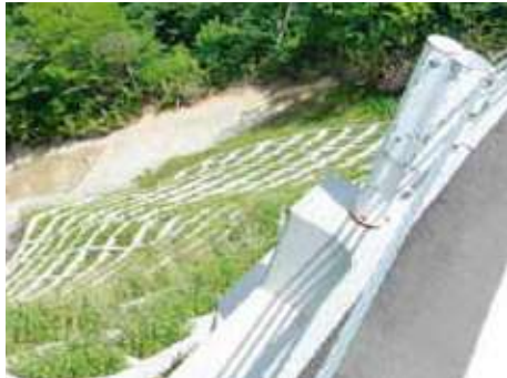
写真-3 天端状況（オーレン）
