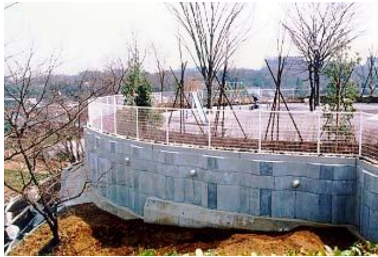
親杭パネル壁工法施工事例
