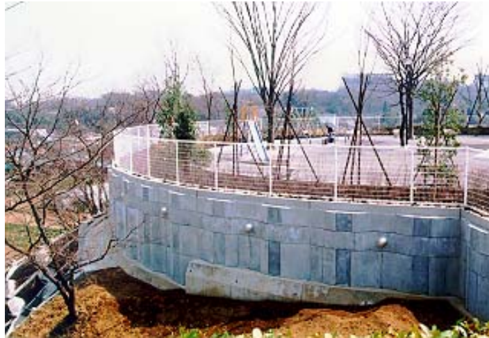
親杭パネル壁工法施工事例
