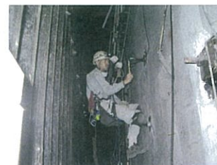
グラウンドアンカーの健全度探査
