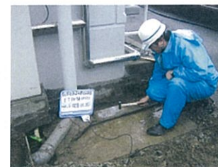
地震被害を受けた建物基礎杭の健全度探査
