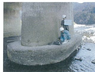
橋梁ケーソンの深度探査
