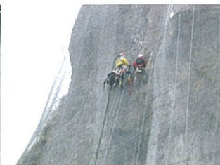
岩盤の内部亀裂探査
