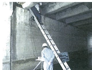
シールド計画路線にある橋台基礎杭探査
