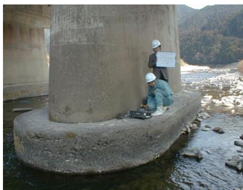
写真-1 橋梁ケーソンの深度調査
