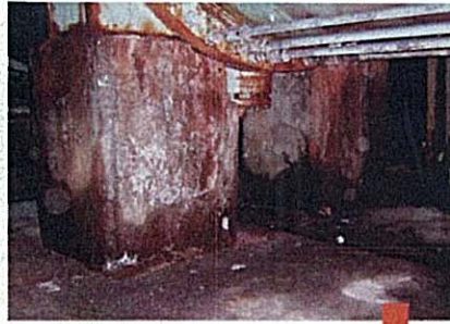
取水管架台 (施工前)
