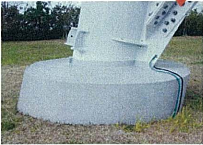
鉄塔基礎 (施工後)
