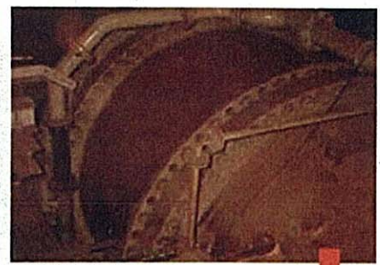
発電所循環水管 (施工前)
