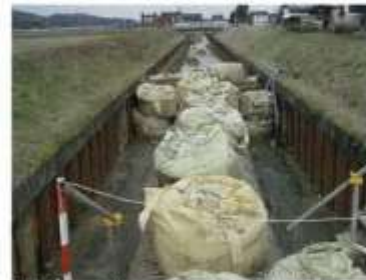
仮設工 排水パイプ設置(仮締切)
