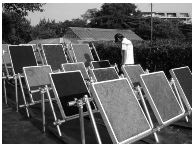
写真-2 施工直後の試験地の様子
