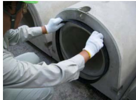
⑥ジョイントゴムの挿入
