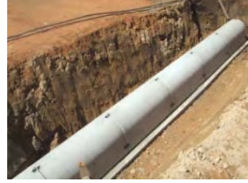
⑩施工完了
