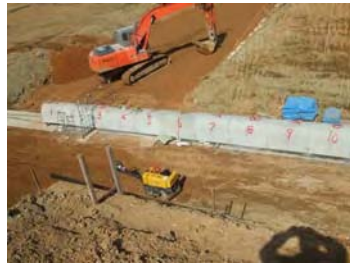
西の峠池地区ため池改修工事（兵庫県）
