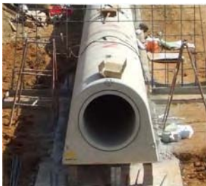
西の峠池地区ため池改修工事（兵庫県）
