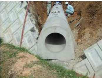
大忠北地区農道改良工事（広島県）
