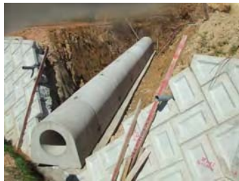
大忠北地区農道改良工事（広島県）
