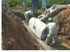
②製品据付け
