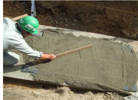
④接合工(接着剤充填)
