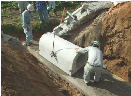
⑤接合工(ジョイントゴム挿入)
