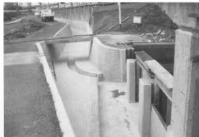
写真-7 施工完了
