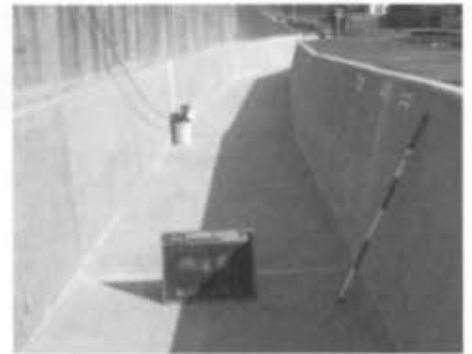
写真-4 施工完了
