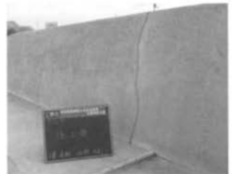
写真-6 施工完了 ひび割れ部
