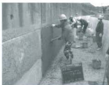
写真-2 ポリマーセメントモルタルコテ塗り状況
