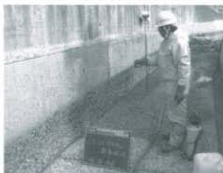
写真-1 コンクリート改質剤散布状況
