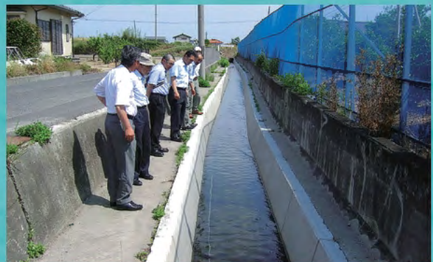
施工現場視察状況
