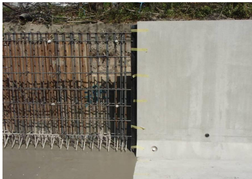
現場打ちとの接続部
