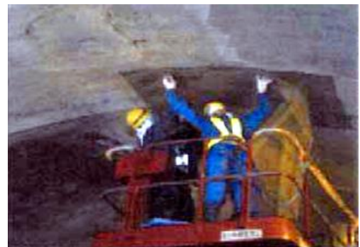
⑤シート補強工
