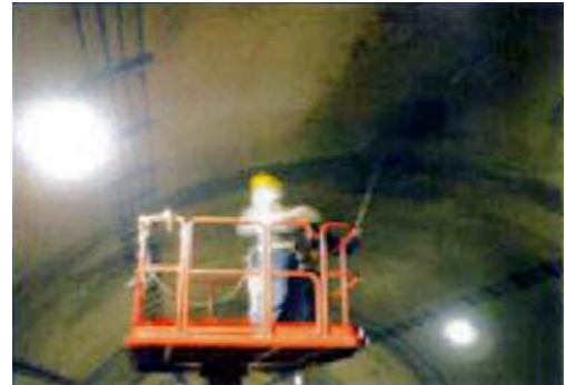
②劣化防止加工
