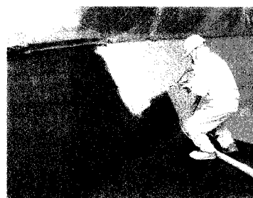
写真-3 ウレタン樹脂吹付け
