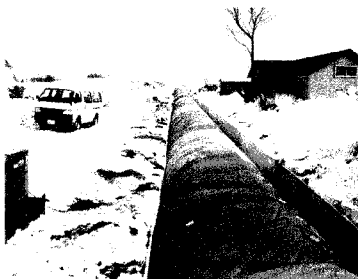
写真-1 仮設養生
