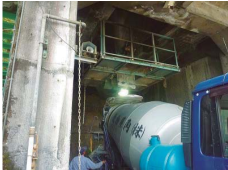
写真-3 材料は生モルタル（現場練りも可）
