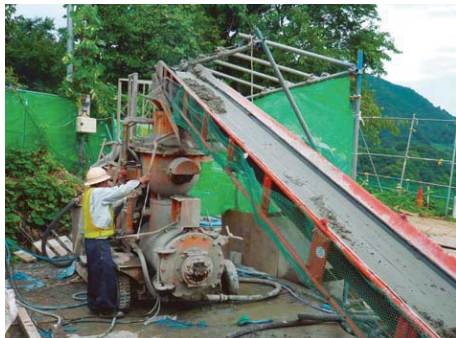
写真-6 材料を汎用の湿式吹付機に投入
