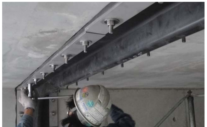
押さえ板取付状況
