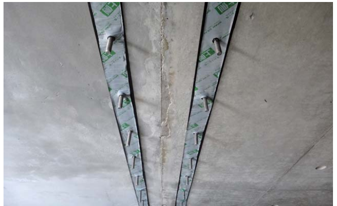
シール材貼付け状況
