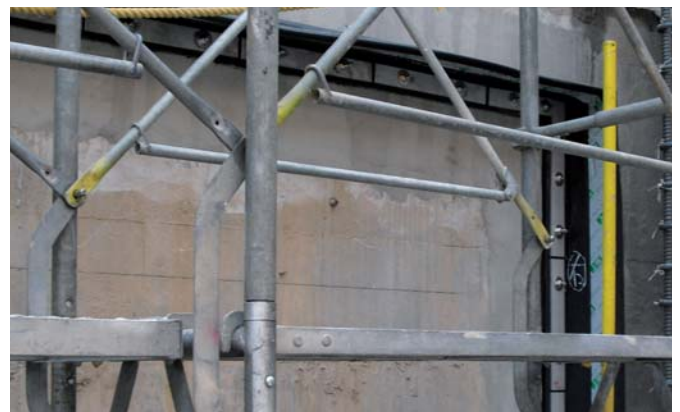
仕上がり状況
