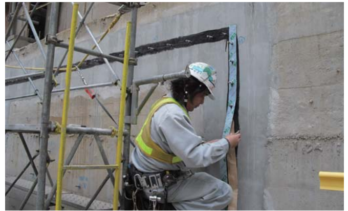
シール材貼付け状況
