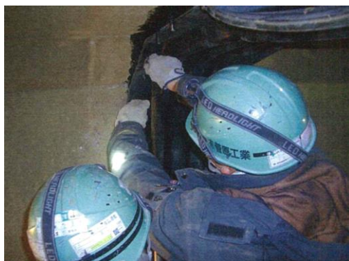
伸縮ゴム取付
