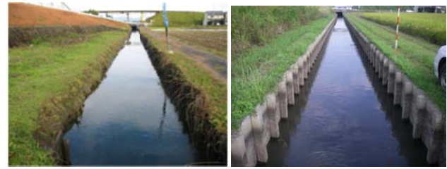
(a) 改修前（土水路） (b) 改修後（板柵工）
