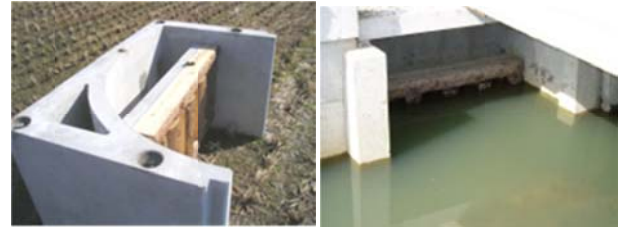
図-2 人工ワンドの設置（宝江川）
