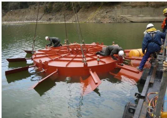
水中組立状況
