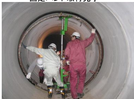
固定バンド取付完了
