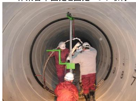
作業台車固定と固定バンド取付
