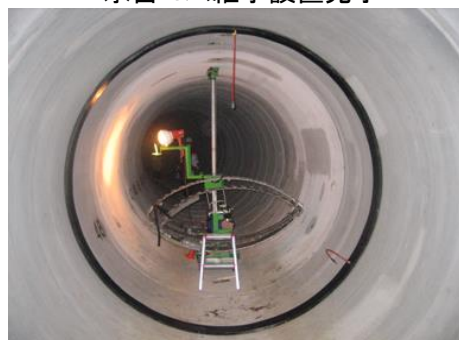
水密ゴム継手設置完了
