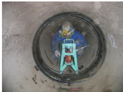
油圧ジャッキで固定リング拡張
