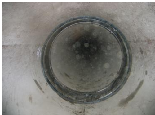
止水バンド設置完了
