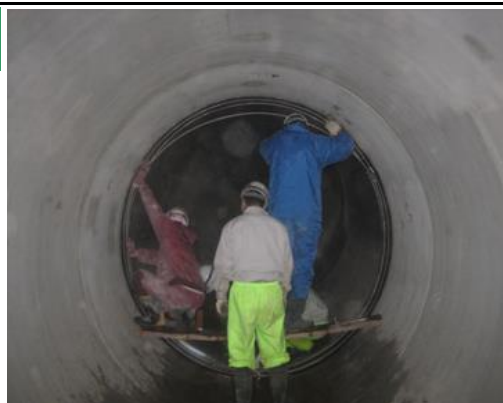
油圧ジャッキで固定リング拡張
