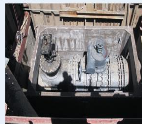
機器据付状況
