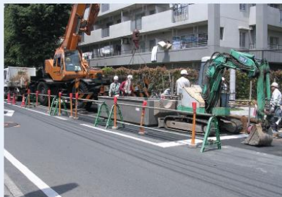
市街地での施工
