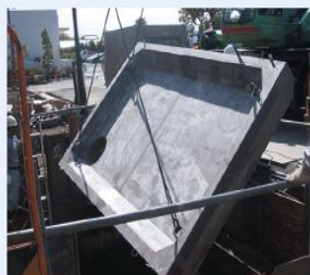
下部底板据付状況
