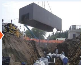
③上部ブロック据え付け
