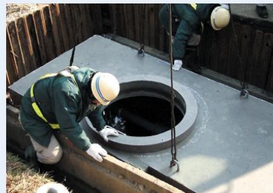
狭隘地での施工
