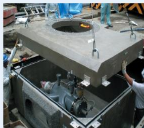
下部、上部据付
