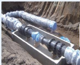
①下部ブロック設置と配管
