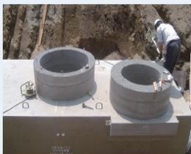
④調整リング設置(接着)
