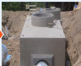
⑤設置完了
