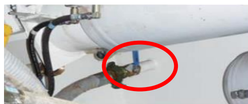
②シールド機内のクレーショック注入孔(下方部)
