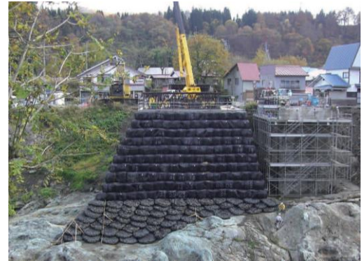
▲仮設構台 (耐候性大型土のう・ジオテキスタイルとの併用)
