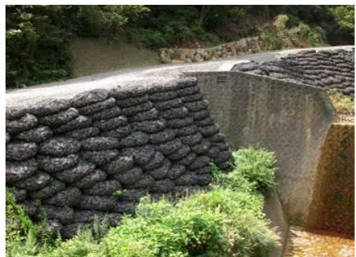
▲砂防堰堤管理用道路
