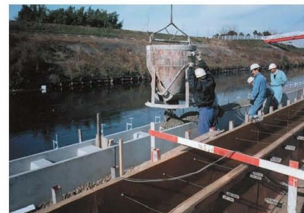
7.コンクリート打設
