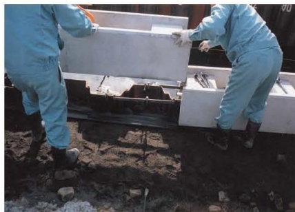
3.幅止め金具の取り付け
