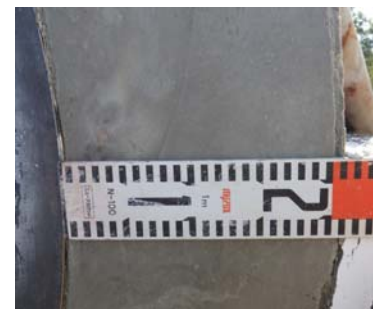
写真-4 裏込め厚確認
