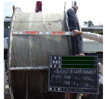
写真-3 打設長確認
